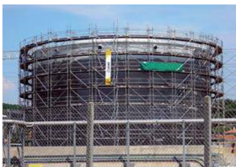
▲ Mantenimiento en depósito circular
