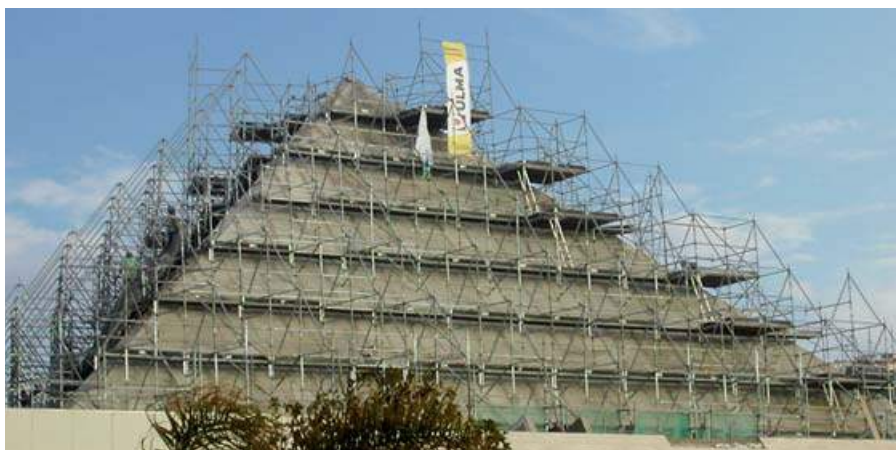
▲ Andamio Multidireccional BRIO en fachada inclinada
