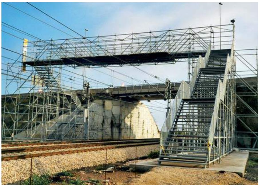
▲ Pasarela peatonal para salvar vías del tren
