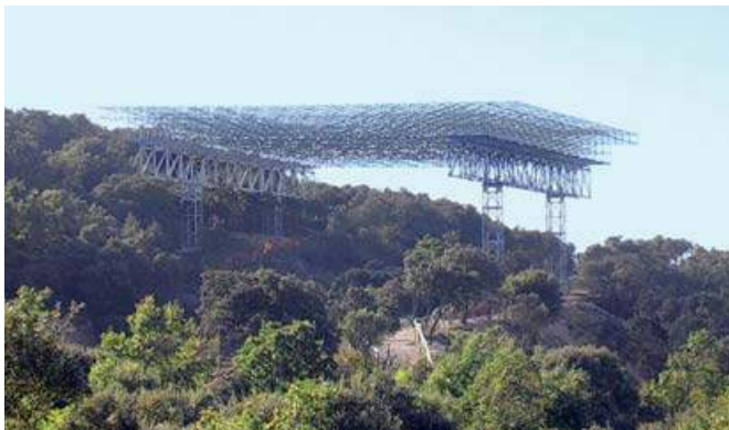
▲ Cubierta de 22 m de luz realizada con elementos estándares de BRIO
