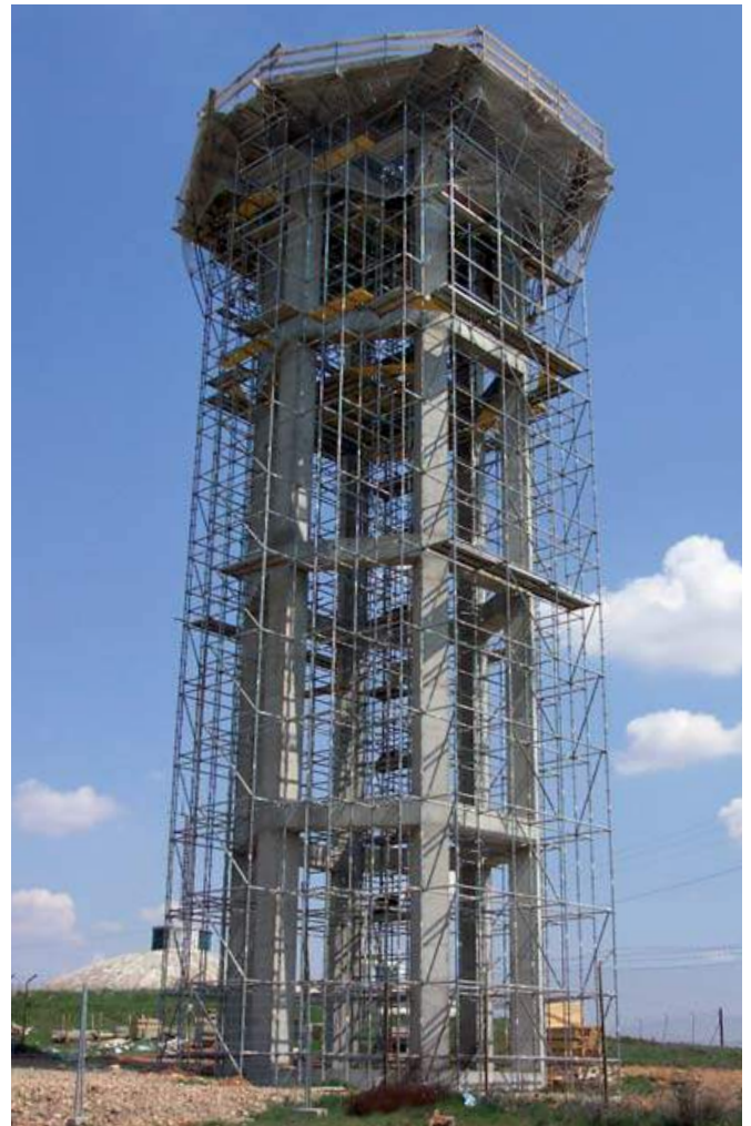
▲ Apeo de depósito a 24 m de altura
