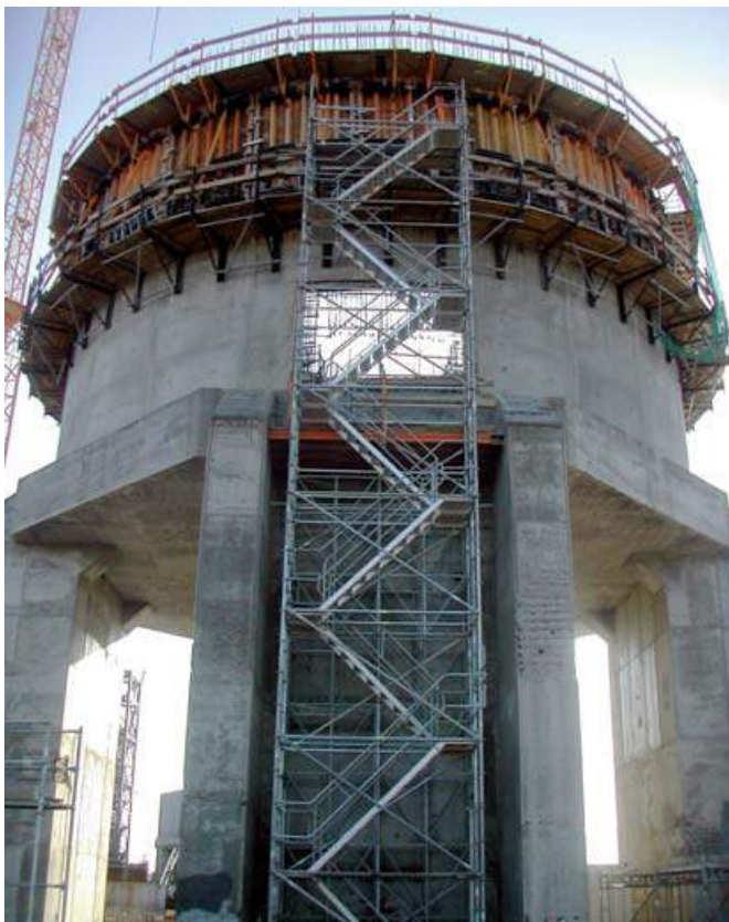
▲ Acceso al encofrado en ejecución de silo
