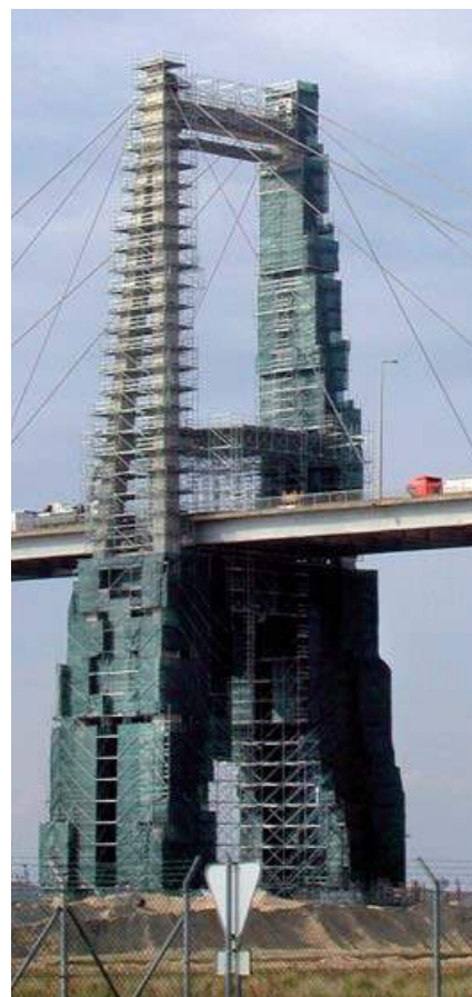
▲ Restauración del Ponte Figueira Da Foz, Portugal
