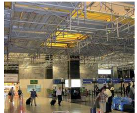
▲ Plataformas de trabajo bajo cubierta
