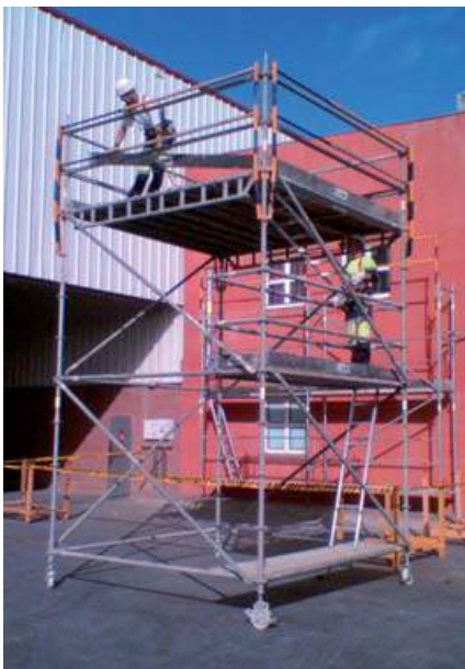
▲ Montaje de torre móvil con pies de seguridad
