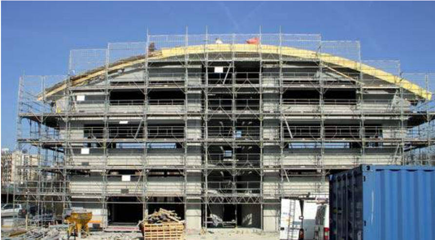
▲ Protección de borde de tejado en obra nueva
