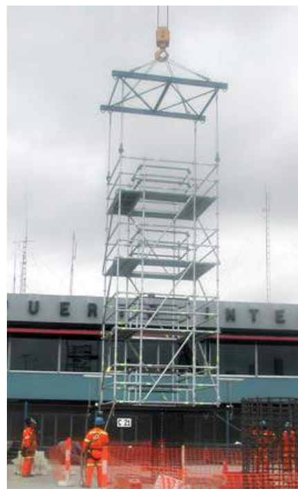
▲ Izado y traslado de torres
