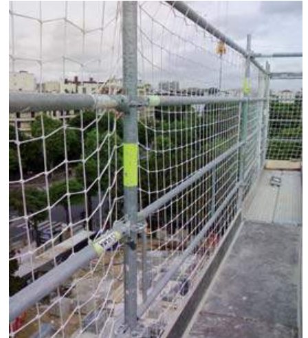
▲ Red de protección reforzada perimetralmente
