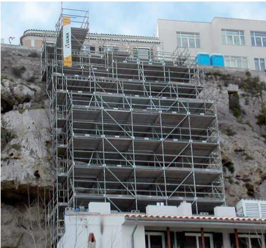
▲ Montaje de andamio sobre acantilado
