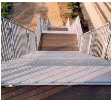
▲ Peldaños metálicos y descansillos de madera antideslizantes
