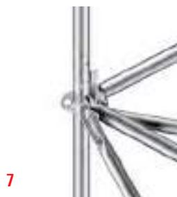
(7) Con un simple golpe de martillo sobre las cuñas se rigidizan las uniones. En ocasiones puede ser necesaria la colocación de una diagonal en planta para rigidizar planos horizontales cuando éstos no lleven plataformas.
